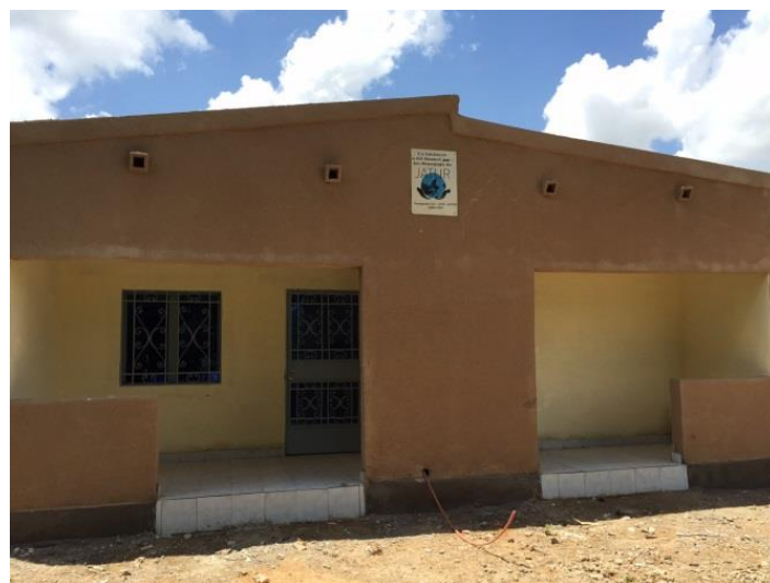
Etat des travaux en septembre 2015
