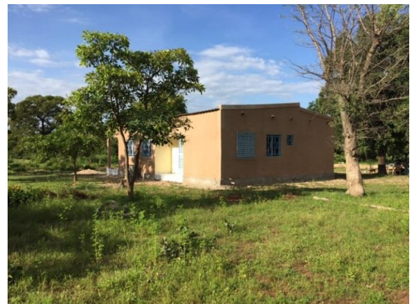
Etat des travaux en septembre 2015
