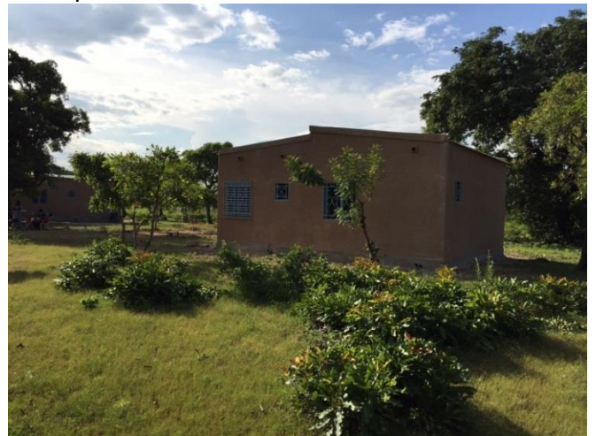
Etat des travaux en septembre 2015
