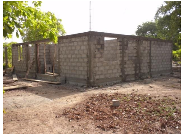
Etat des travaux au printemps 2015
