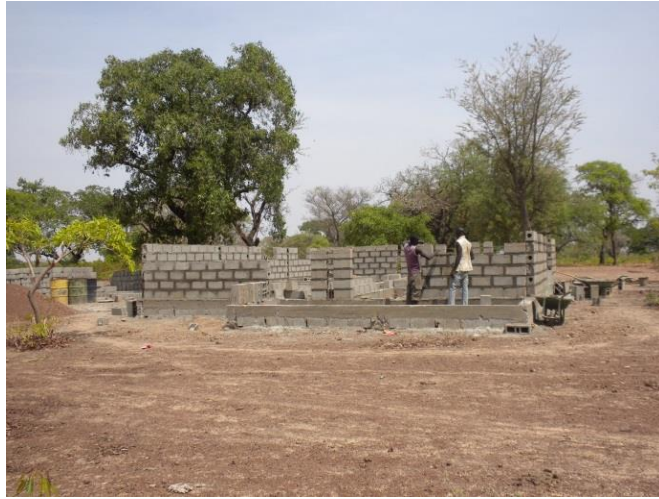
Etat des travaux au printemps 2015
