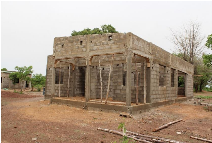
Etat des travaux en été 2015
